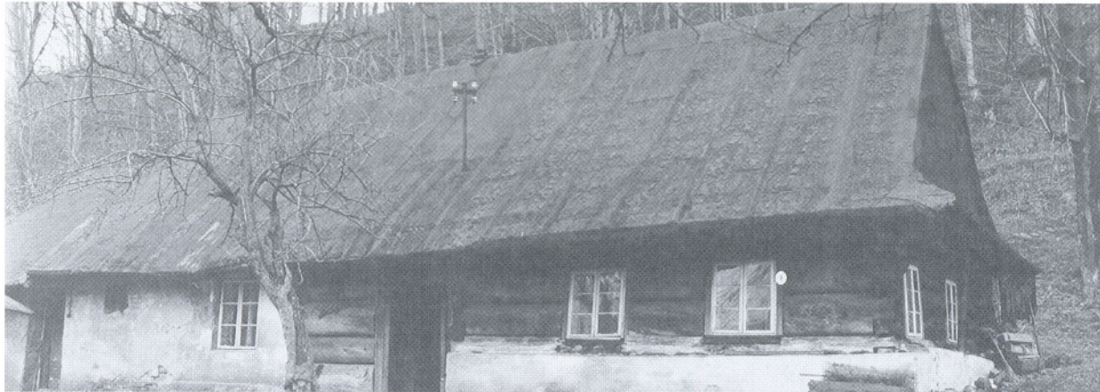
Roubený dům na vysoké podezdívce se zděnou hospodářskou částí pod společnou střechou. (Řeka č. 7, okr. Frýdek – Místek)
