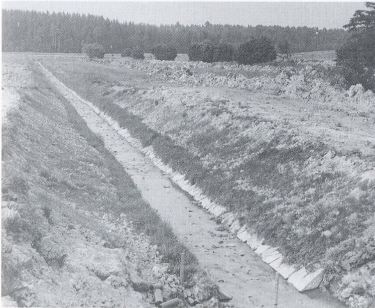
Zejména v počáteční fázi technických úprav toků byla nejnižší část nových koryt opevněna a tím byl vlastně vodní tok zkanalizován.
