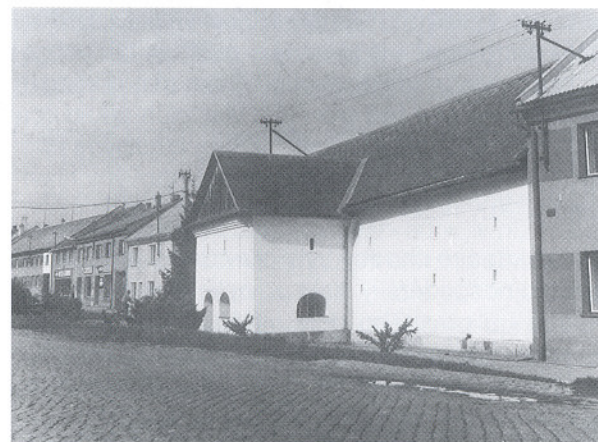
Představené žudry hanáckých domů s přízemní lodžii, patrem se štítem a často s polovalbou. Bílý nebo sytý barevný tón s bílým rámováním stěny a otvorů. (Příkazy č. 26, okr. Olomouc)
