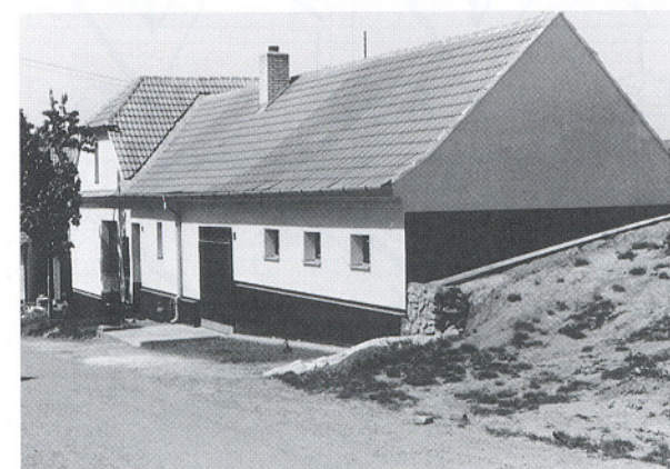
Vzorná obnova střech
