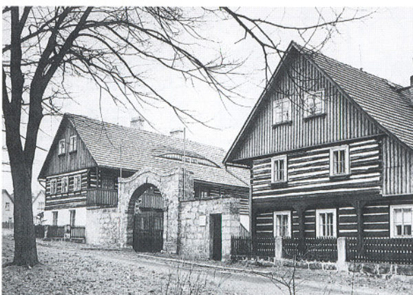
Ukázky příkladné rekonstrukce budov.
