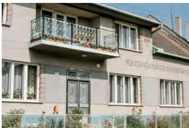
Přestavba usedlostí představovala také nadstavbu a nový styl: široká dvojitá okna, průčelí potažená šedým břizolitem, i novinka: okrasný balkónek. Vodorovné pásy mezi okny měly průčelí modernizovat, členité zábradlí a sgrafito jí měly ozdobit.
