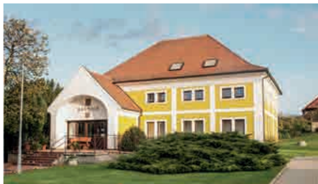
ŠITBOŘICE na Kloboucku
