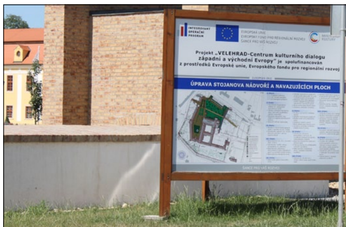
Rekonstrukce Stojanova nádvoří
